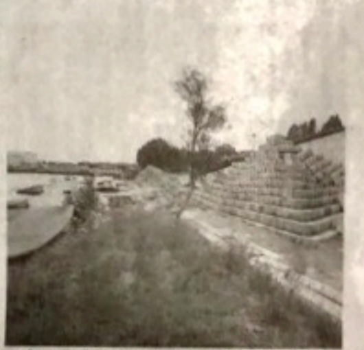
東日本大震災の津波で海辺の施設が流失した仙台港中央公園。かつてホームレスが寝泊まりしていたという=2011年6月1日、仙台市宮城野区港2丁目、同市提供
